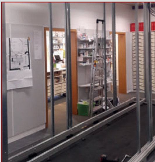
Aufbau der Kommissionieranlage
