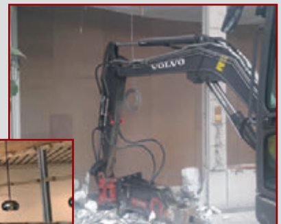
Eneuerung der Fassade
